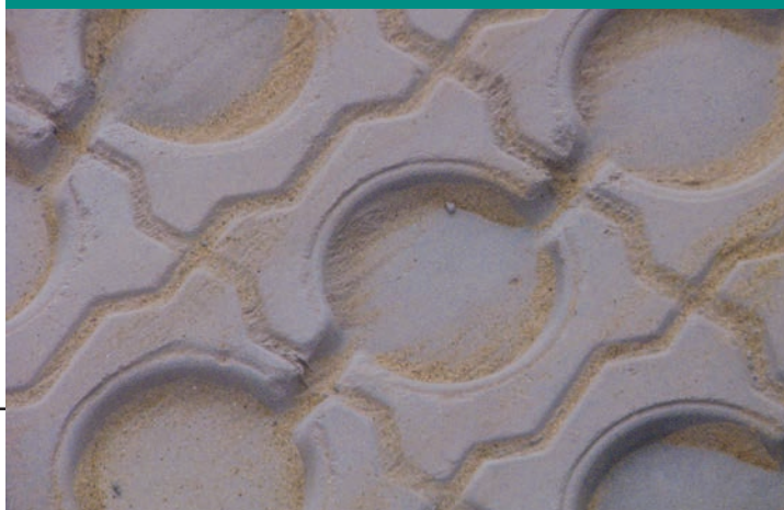
Detalhe do piso antiderrapante
