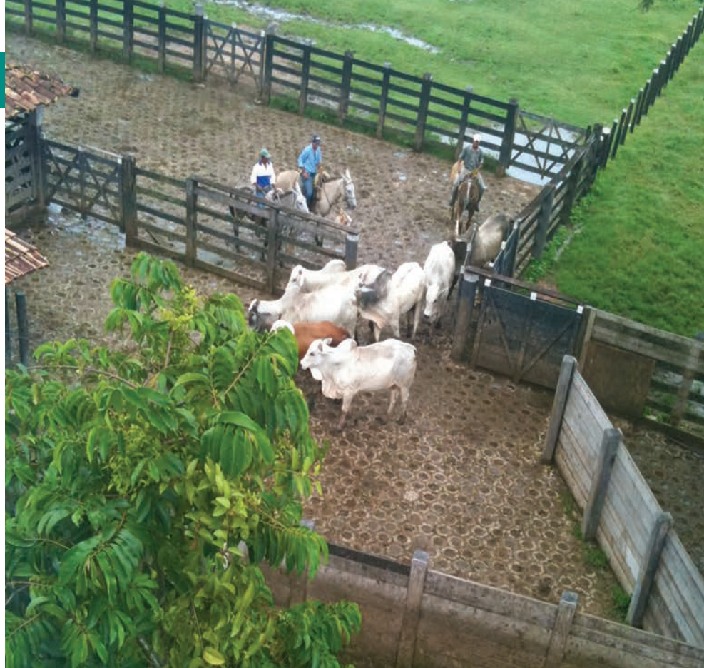
Piso antiderrapante instalado no curral da Fazenda Teolinda completou dez anos
